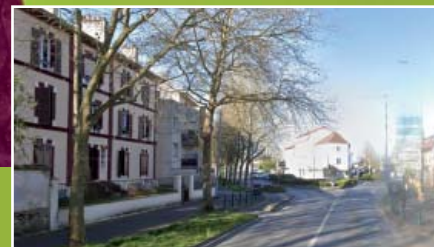
P20 Travaux au carrefour du « Grand Cerf » du 12 au 30/09
