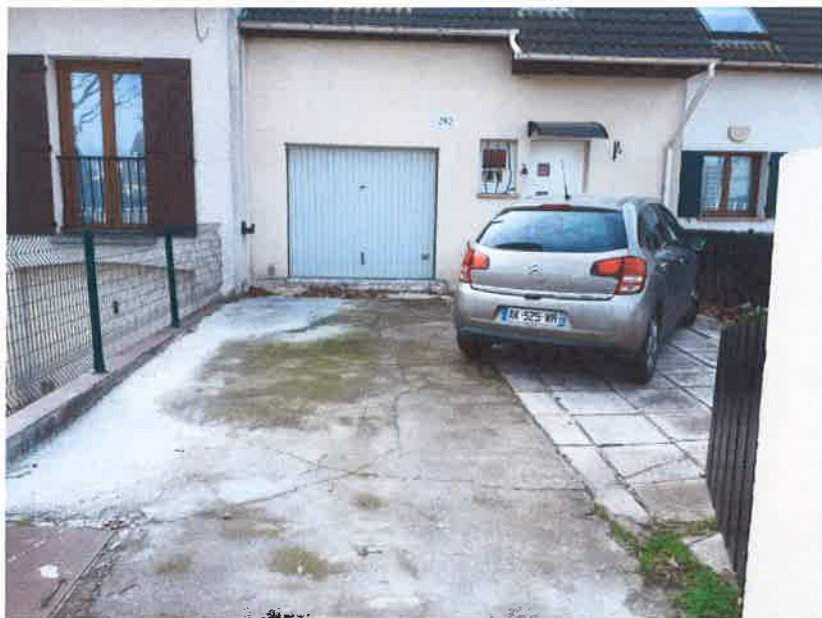
Projet avant travaux
