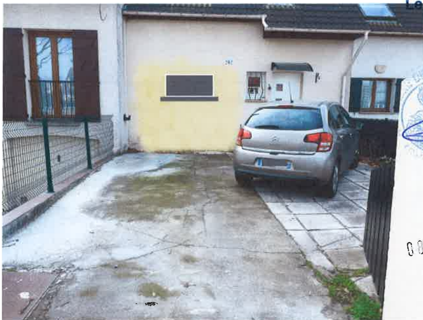
Projet apres travaux.
