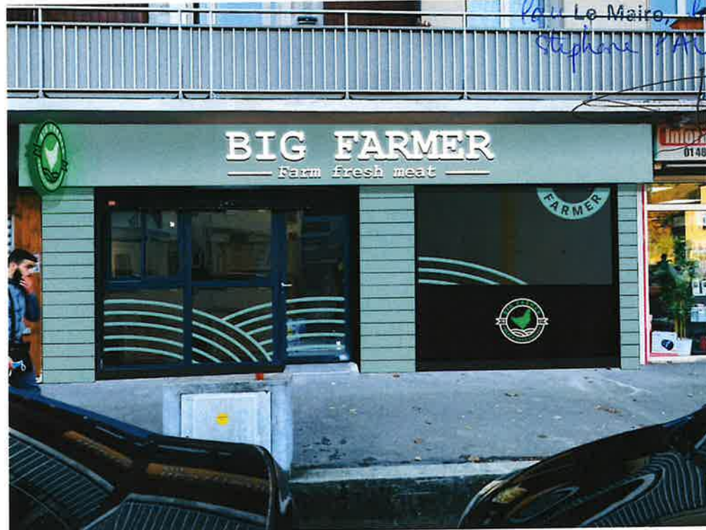
FAÇADE EST APRÈS INTÉRVENTION
