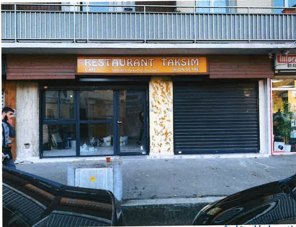
FAÇADE EST AVANT INTÉRVENTION
