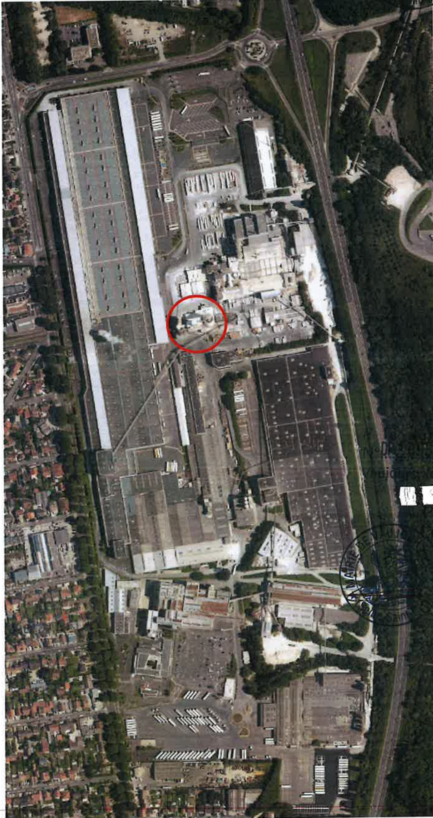
Localisation du bâtiment réhabilité
